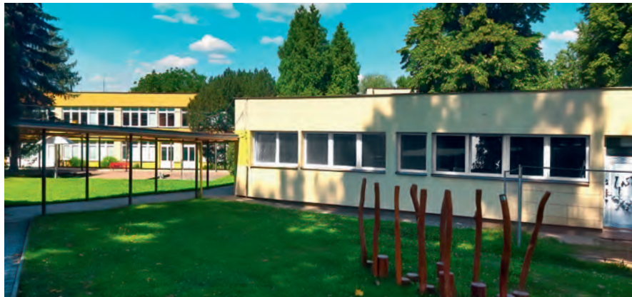
Hospodářský pavilon v MŠ Slunečná se dočkal rekonstrukce. Foto Ondřej Halama
