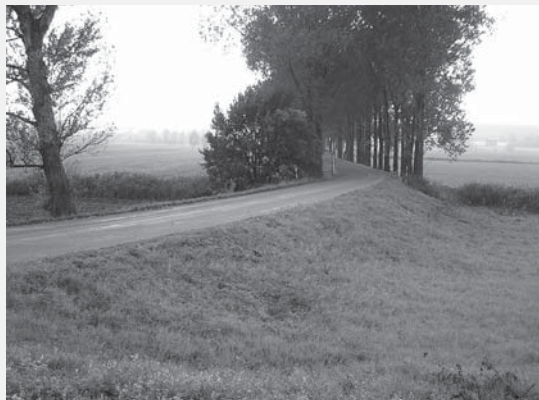
Nynější silnice od Tisové vedoucí u Hrušové po hrázi zrušeného rybníka. Foto Radim Urbánek, 2003.
