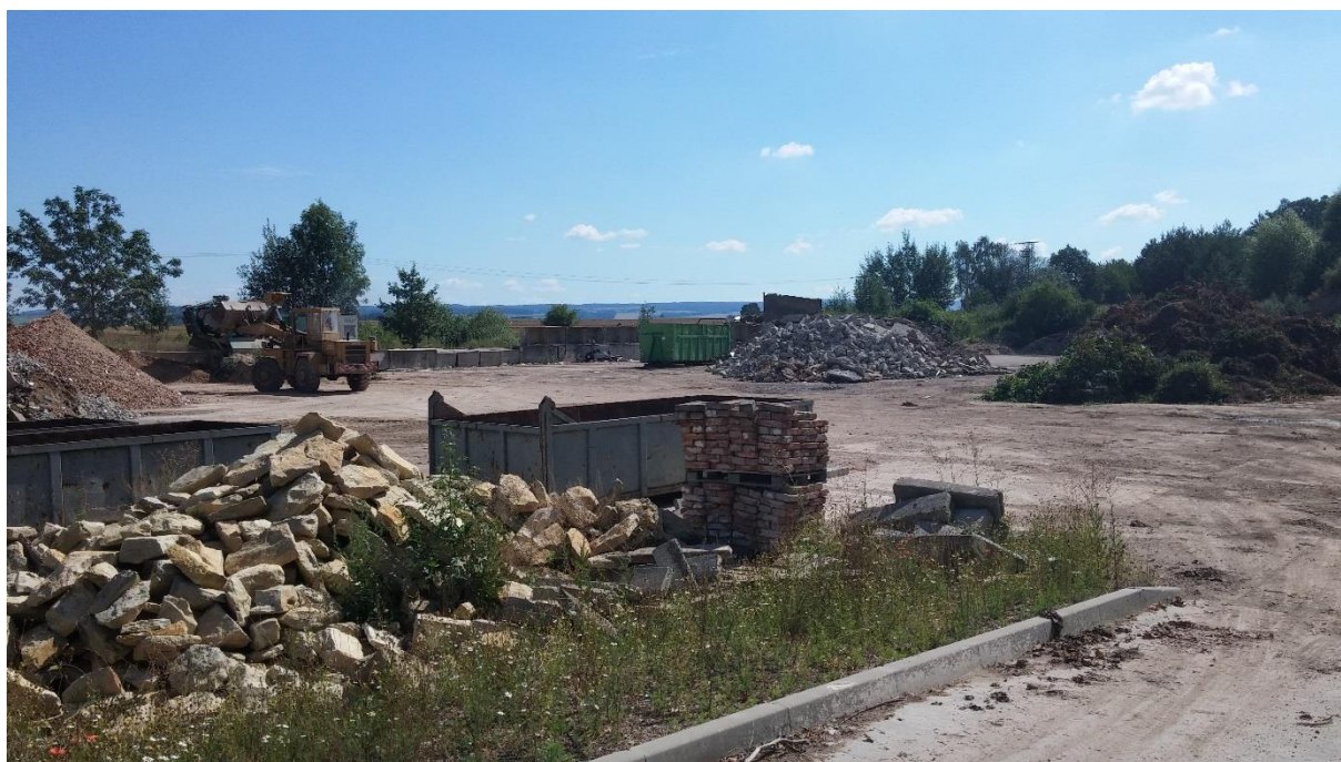
Obrázek 15 - Odložná plocha pro stavební a demoliční odpad - Recyklační středisko
