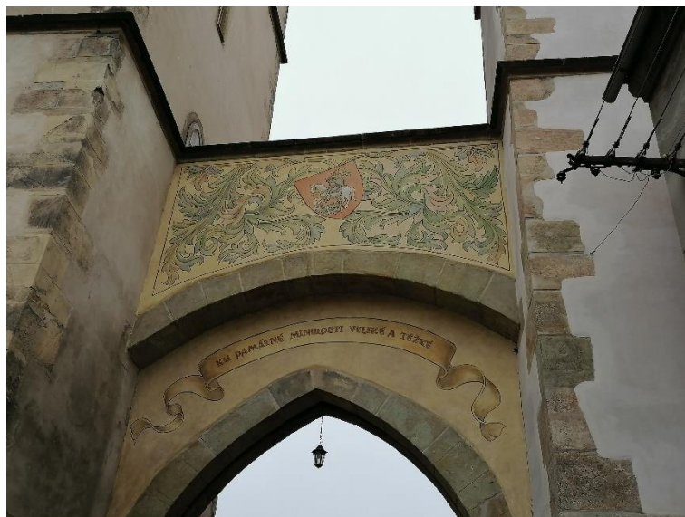
Obr.: Restaurovaná sgrafita na Pražské bráně – východní strana
