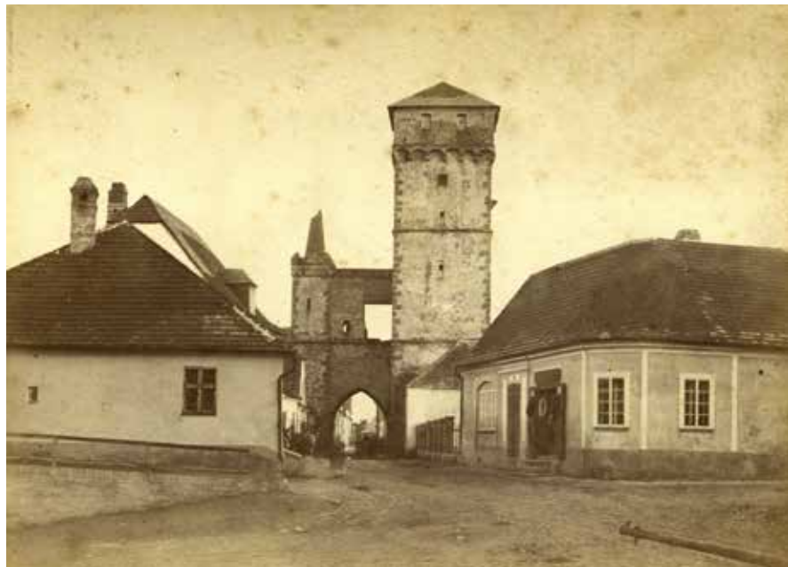
Pohled na Pražskou věž před přestavbou (před r. 1882), foto Ferdinand A. Brožek, sbírka RMVM.
