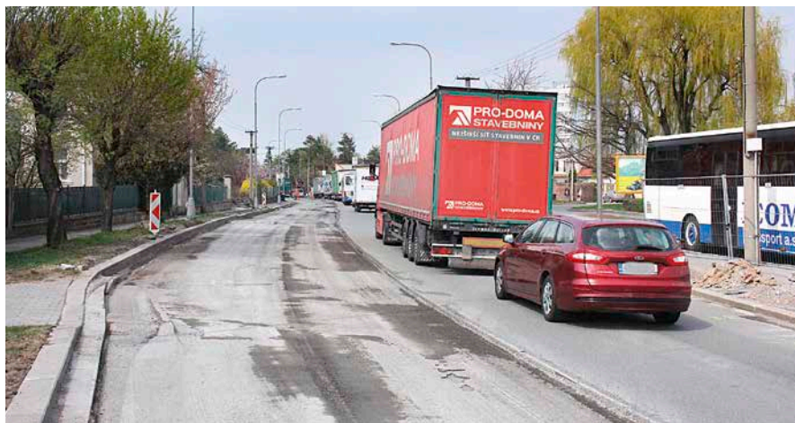
Hodně rušno bude v následujících týdnech na silnici I/35 ve městě. Foto Aleš Felgr
