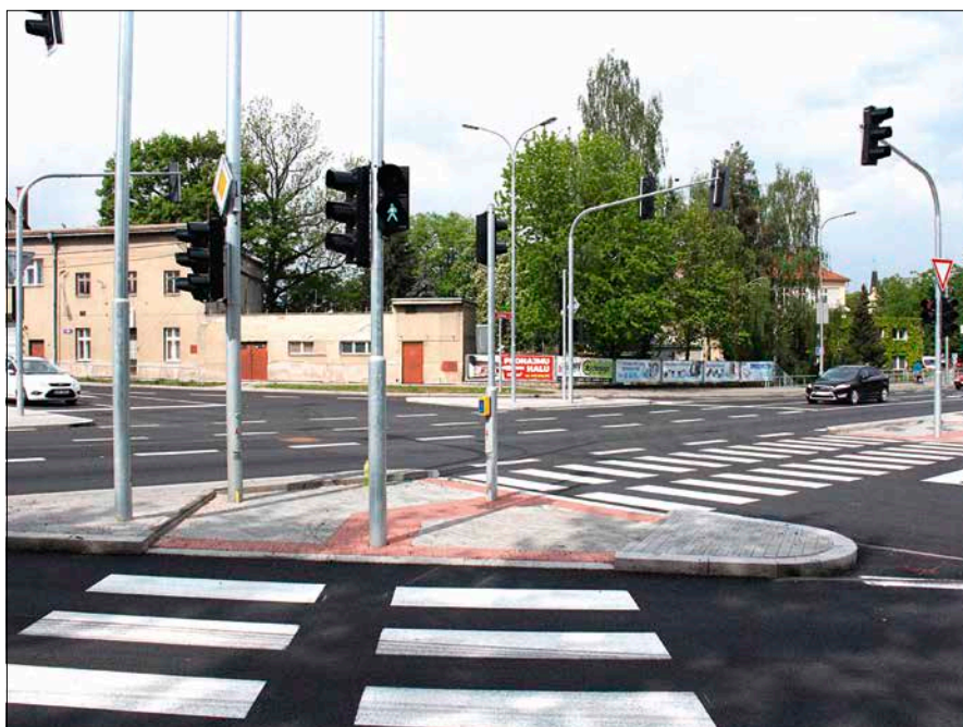
Nové semaforey na silnici I/35 už jsou částečně v provozu. Foto Aleš Felgr
