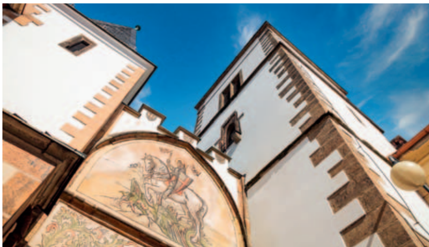
Oprava brány v Tůmově ulici pokračuje. Foto Aleš Felgr
