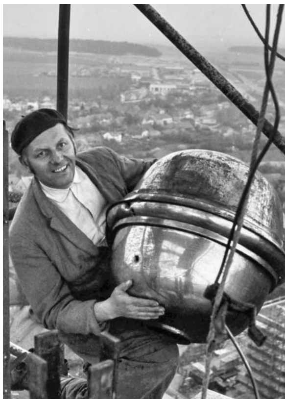
Stavbyvedoucí z Městského stavebního podniku František Schejbal, který drží na lešení sejmutou makovici z jižní věže kostela. Foto autor neznámý, sbírka RMVM
