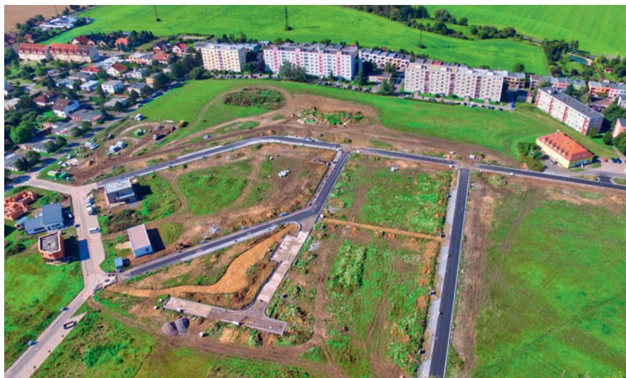
Infrastruktura pro stavbu rodinných domů. Foto archiv město Vysoké Mýto
