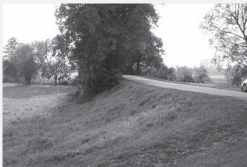
Silnice mezi Tisovou a Hrušovou vedoucí poblíž Pekel po hrázi zrušeného rybníka. Foto Radim Urbánek, 2003.
