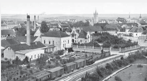
Pohled z budovy měšťanského pivovaru na část Vysokého Mýta. Vpředu smíšený vlak v čele s lokomotivou řady 195 Císařsko-královských státních drah (později 300.4 ČSD), vlevo budova Kurkových lázní a kovotlačitelství, vedle vpravo Šimova vila a v pozadí Pražská věž, rok 1910.
