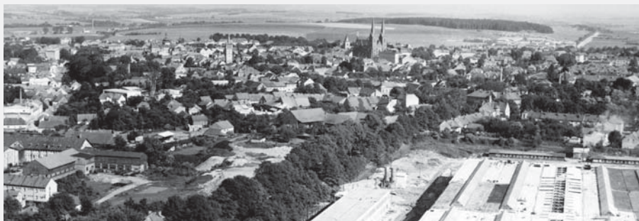
Pohled z komína kotelny v Karose na město. Vpravo dole výstavba nových závodních prostor. Foto: J. Teplý, 1968.
