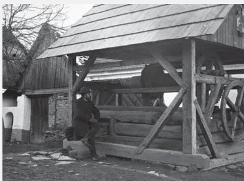
Studna v Domoradicích s dřevěným rumpálem se sekernícky zhotovenými převody na principu palečnických a cévních kol. Foto: autor neznámý (sbírka RMVM), 90. léta 19. století.
