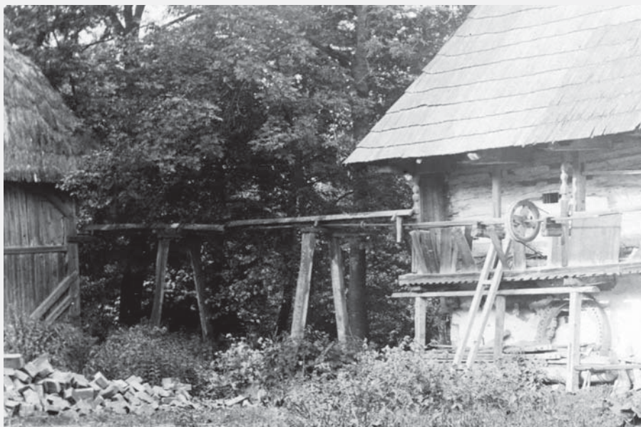
Přenos pohonu do stodoly plochým řemenem a kovovou transmisí ve mlýně Spálenci čp. 185 ve Vysokém Mýtě. Sběrka Regionálního muzea ve Vysokém Mýtě, foto asi J. Mašek, kolem 1920.
