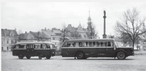
Autobusové vlečné vozy byly vyráběny jak k novým autobusům, tak i k autobusům, které ve Vysokém Mýtě nikdy karosovány nebyly.
