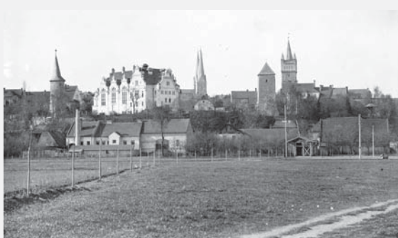
Pohled na dominanty Vysokého Mýta ze sportovního hřiště. Zleva - Klášterská bašta, sokolovna, věže kostela sv. Vavřince, Vodárenská věž a Pražská věž. Foto Josef Králík, 1903.
