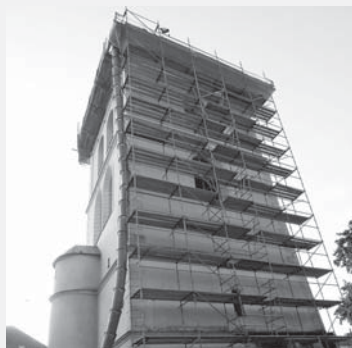
Zvonice ukrytá pod lešením. Foto: J. Danko
