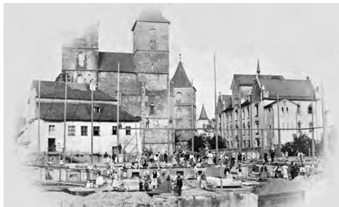
Staveniště gymnázia se starým děkanstvím v pozadí. Foto Ferdinand A. Brožek, asi 1880, sbíрка RMVM
