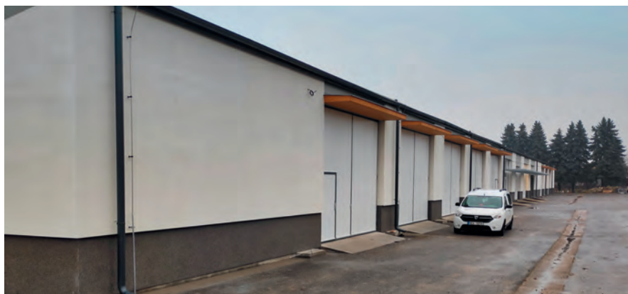
Hala pro velkou muzejní techniku a pro učebny odborné výuky je těsně před dokončením. Foto Jiří Junek
