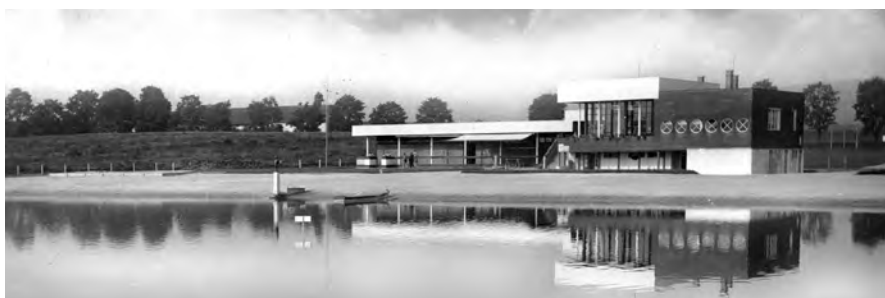
Vysokomýtská plovárna krátce po svém dokončení v roce 1933. Foto Jan Popelka
