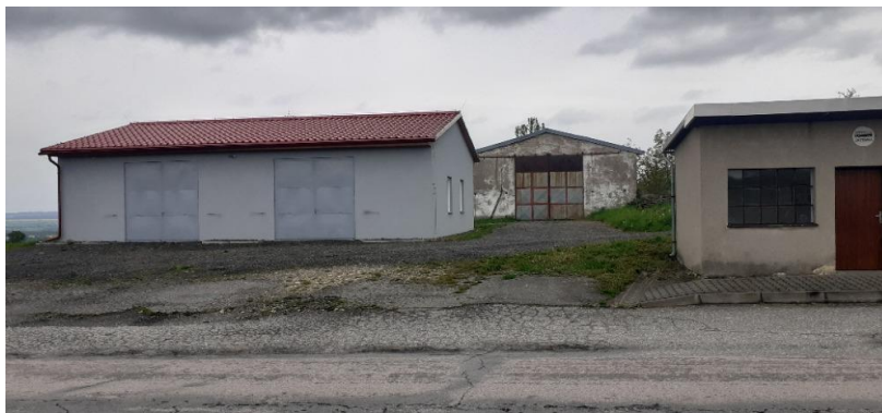
Pohled ze silnice II. tř. – okraj bývalého zemědělského střediska. V popředí novostavba garáží, v zadní části stávající objekt stáje.
