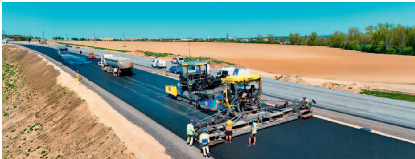
Asfaltování dálnice. Foto ŘSD
