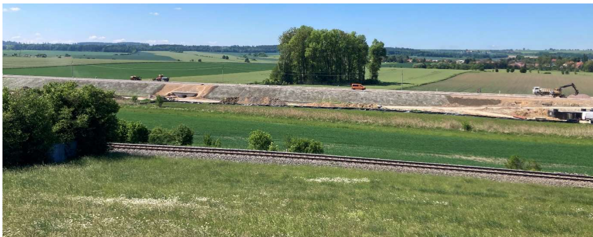
Stavba dálnice D35 v obci Hrušová. Zdroj: ASITIS s.r.o.
