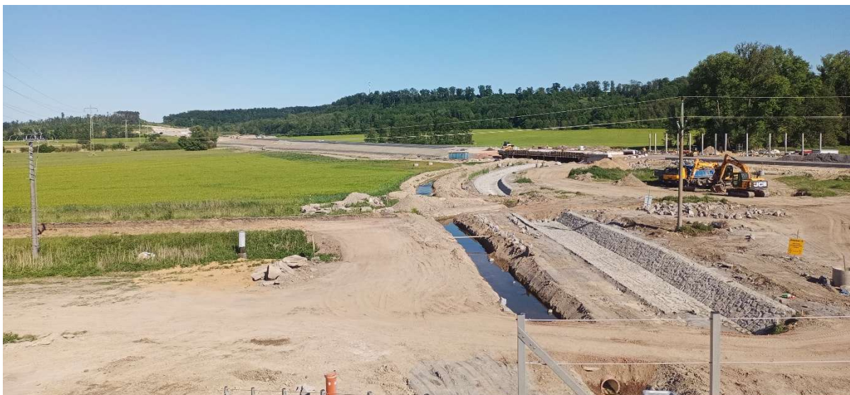
Nové koryto řeky Loučné v rámci stavby dálnice D35, obec Vraclav. Zdroj: ASITIS s.r.o.
