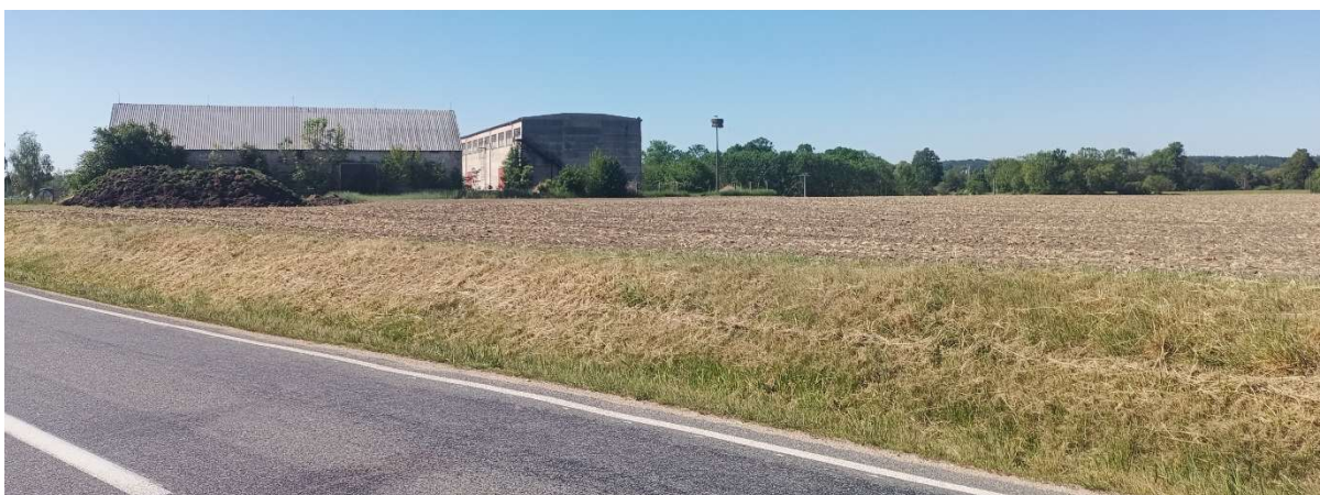
Pohled na brownfield, bývalý zemědělský areál v Plchovicích, s výraznými stavbami a navrženou izolační zelení v ÚP, dosud nerealizovanou; obec Plchovice. Zdroj: ASITIS s.r.o.
