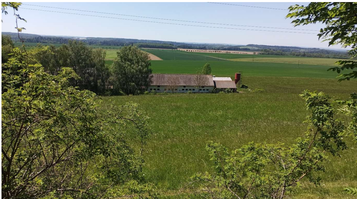
Pohled na brownfield, bývalý velkostatek v Leštině, který negativně ovlivňuje ráz obce; pohledově se uplatňuje především ze silnice II/356, zde pohled ze silnice II/357; obec Leština. Zdroj: ASITIS s.r.o.
